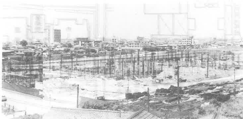
県立芸術会館新築 工事現場
